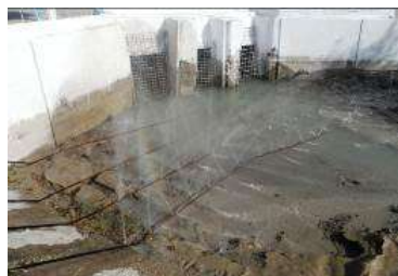
14 – расм. Йўлдош насос станцияси аванкамерасида тешикли қувурларга босимли сув оқимининг берилиши
