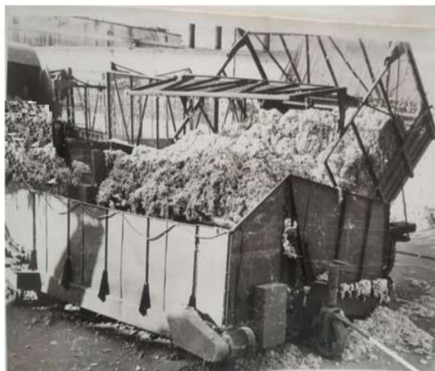
Рисунок 11. Усовершенствованное приема-подающая устройство для хлопка ХПП-III в процессе работы
