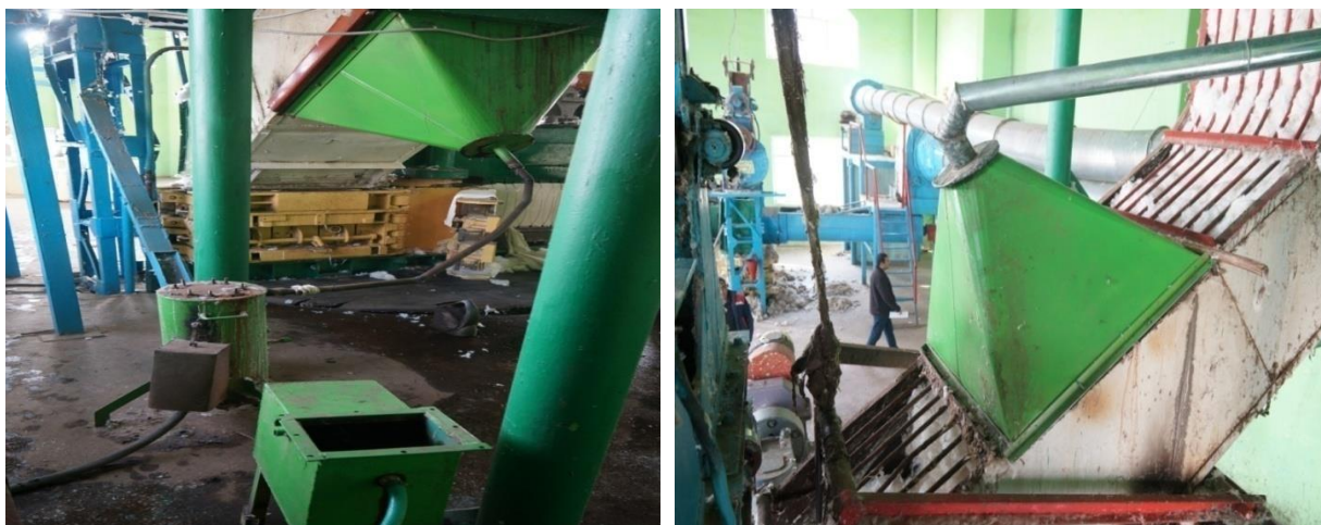
12-расм. Толани намлаш ускунасини монтаж қилиш жараёнидан лавҳалар
