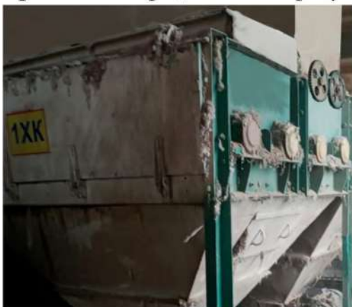
Рис.10. Общий вид при установке питателя между третьим и четвертым барабанами
