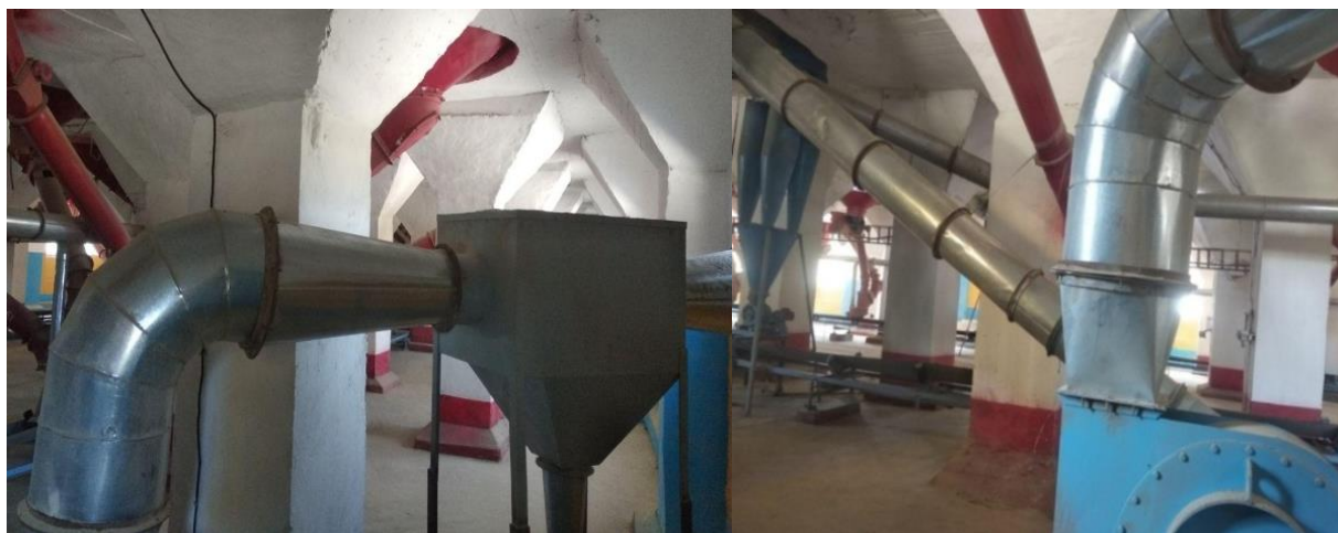
11-расм. Ишлаб чиқаришда ўрнатилган энерготежамкор майда тўрли чанг тутгич ускунасининг синов жараёни.
