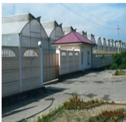
Рисунок 6. Внешний вид современных предприятий, где предусмотрена их защита от проникновения имаго вредителей: 1–теплица нового типа, построенная в 2018 году, 2 и 3–защита форамуг капроновой сеткой.
