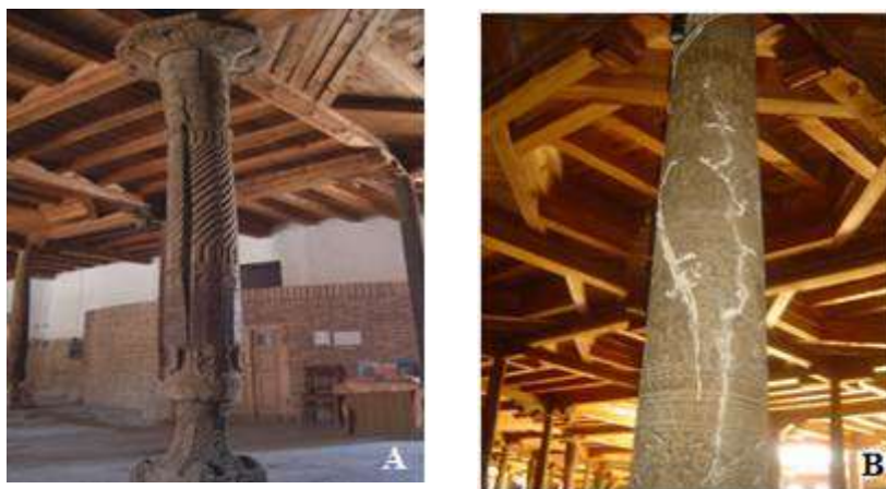
3-расм. Устунларнинг механик (А) ва биологик (В) шикастланиши
