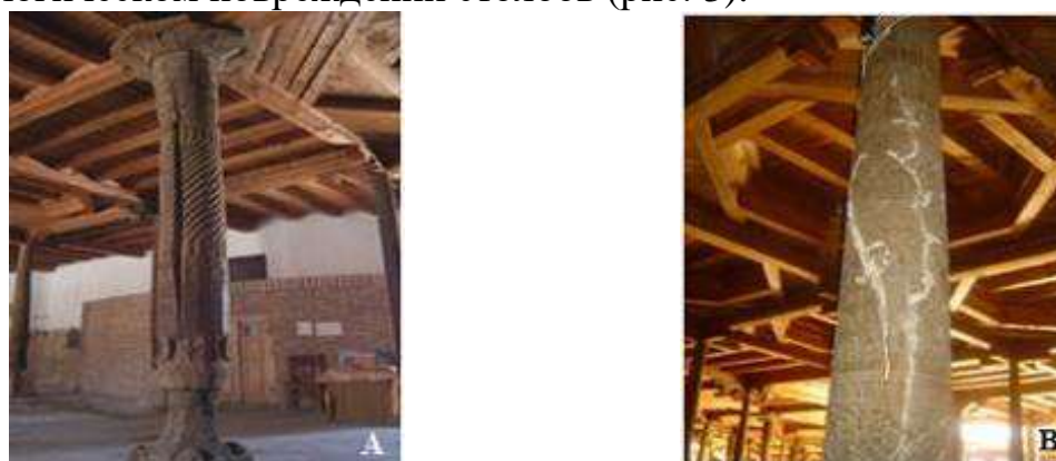
Рис. 3. Механическое (А) и биологическое (Б) повреждение колонн
