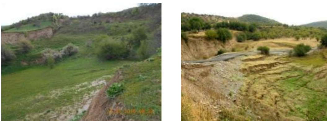
Рис. 3. Зоны и трещины на нижнем откосе.
